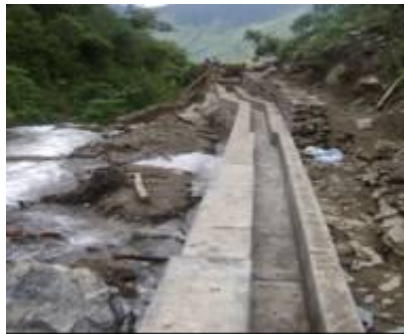
Canal de Riego Pumararra Matibamba, Salcabamba
