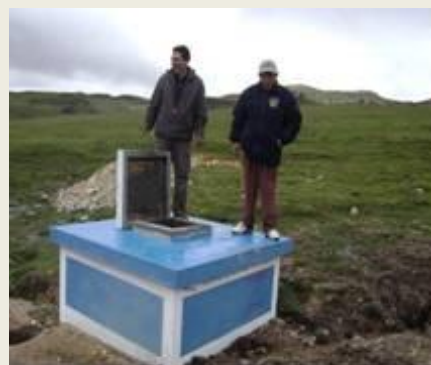
Agua y alcantarillado Conayccasa Palca
