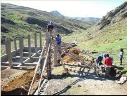
Obra Mejoram.Sistema Agua y Alcantarillado de Ccochaccasa
