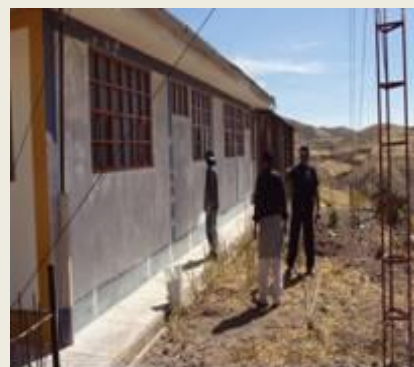
Puesto de Salud de Pacamarca Huaytará
