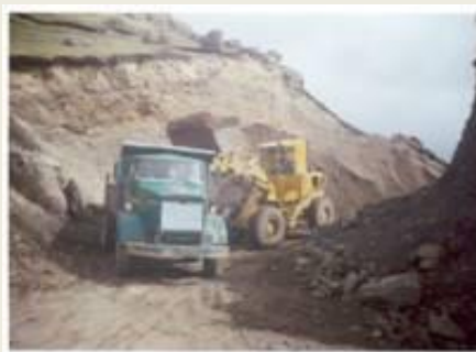
Cargando material para lastrado de carretera
