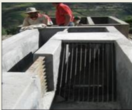
Agua y alcantarillado de Tintay Punco
