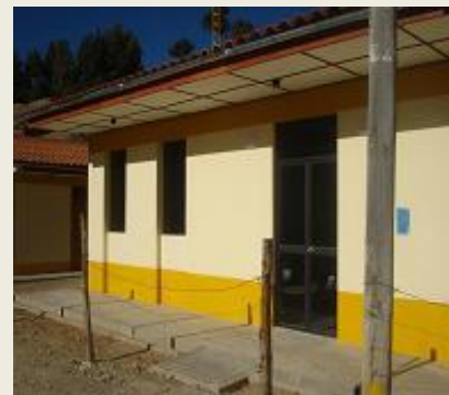
Construc.Puesto Salud de Conchán
