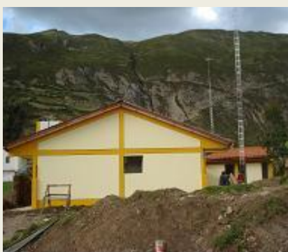
Construc.Puesto Salud de Ccarhuanranra
