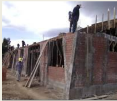
Construc. Puesto Salud de Huanaspampa
