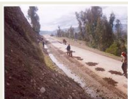
Trabajos de bacheo en conservación de carreteras
