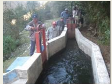
Agua y alcantarillado de Pichus Huaribamba
