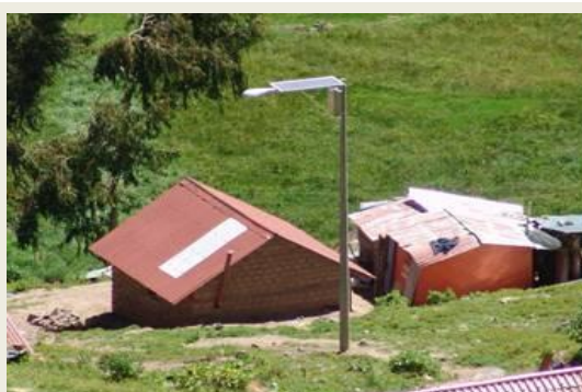
Instalación de redes eléctricas domiciliarias
