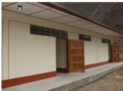
Nueva CE de San Juan-Castrov, afectado por sismo
