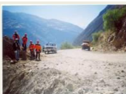
Inspeccionando situación de carreteras por conservar
