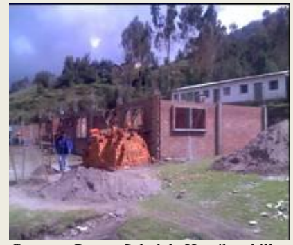
Construc. Puesto Salud de Huaribambilla
