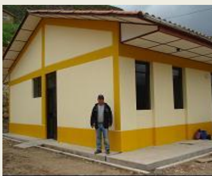
Construc.Puesto Salud de Ccosnipuquio
