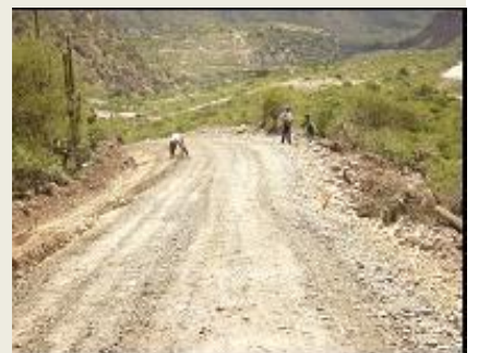
Carret. Acobamba-Anta Illanca
