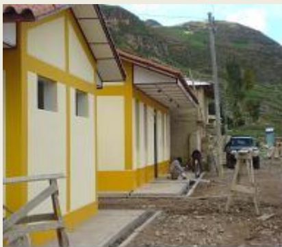
Construc.Puesto Salud de Antaymisa
