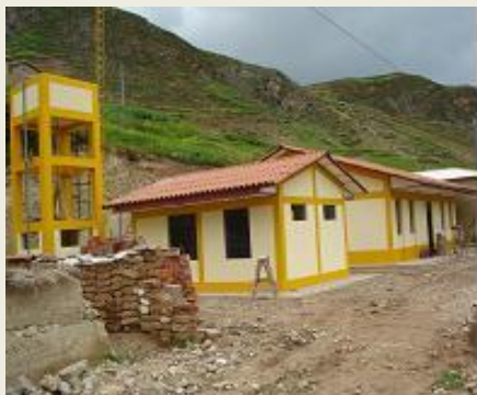
Construc.Puesto Salud de Chaynapampa
