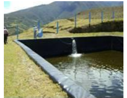
Riego Cebollapta Ayacchocha, Salcabamba
