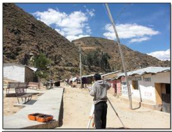
Levantamiento Topográfico para Exp.Téc. PRONOIE Poroncocha-Huaytará
