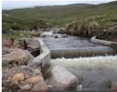
Bocatoma Sumaysunchu – Orcon Py Fortalec. Pequeños Sistemas de Riego Angaraes Sur
