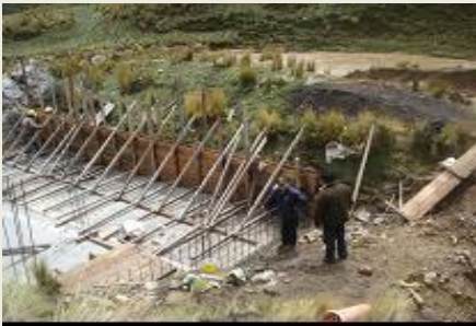
Encofrado muros de lecho de secado, Py Agua y Alcantarillado Huachocolpa
