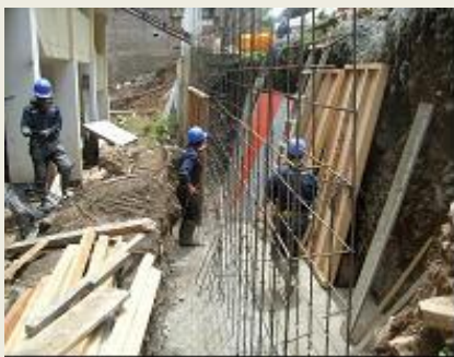
Obra Mejoram.IE Católico Biligüe Isolina Clotet Fernandini de Hvca
