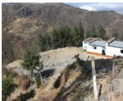
Ie afectada por sismo 2007-Laramarca
