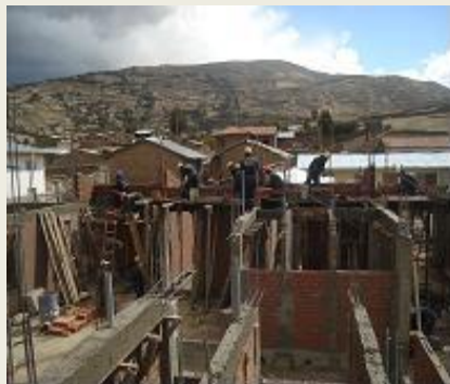
Obra Centro de Salud de Ayaccocha
